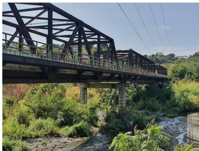
Figura 1. Superestructura de un puente de armadura. Fuente: [11]
