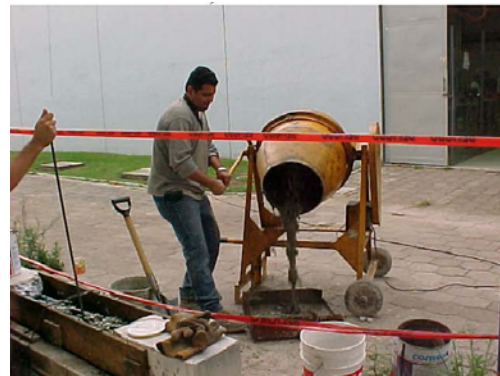
d) Colado del concreto de reemplazo
