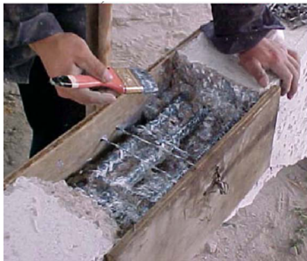
c) Aplicación de Festerbond en superficie dañada
