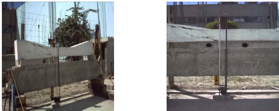
Figura 5. Corrección de flecha utilizando una viga de reacción y gatos hidráulicos.
