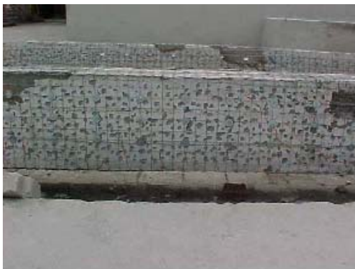
Figura 11. Vistas del anclaje de la malla electrosoldada con las trabes.
