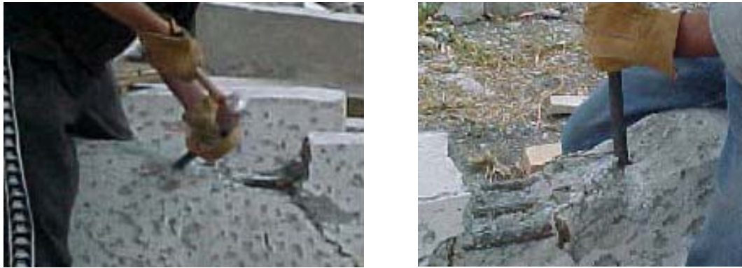
Figura 6. Preparación de la superficie de la trabe.
