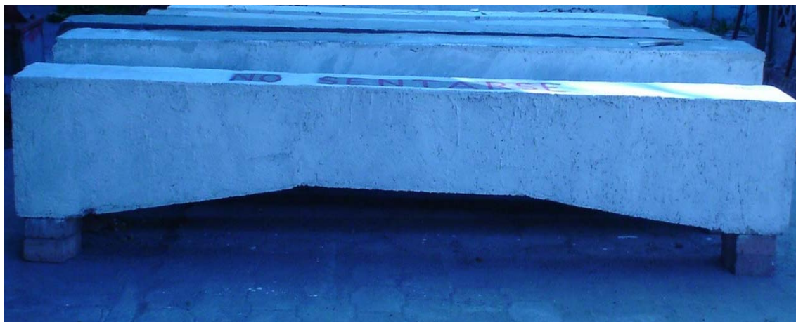
Figura 12. Vista de las trabes reparadas con el encamisado de malla electrosoldada y mortero.
